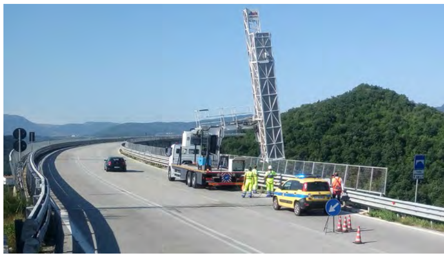
Figura 2 - Molise-Ispezioni con bybridge - S.S. n. 650 Fondo Valle Trigno.
